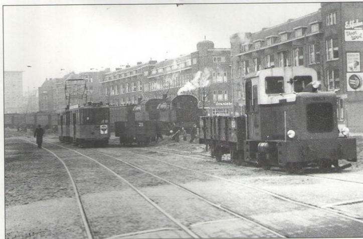
Behalve de NS was ook de RTM zwaar getroffen. RTM-dieselloc tijdens de reparatie-werkzaamheden aan de RTM-lijn op de Brielsestraat te Rotterdam op 5 februari 1953. Links een elektrische tram van de RET en op de achtergrond een werklidentrein van de NS met twee stoomlocomotieven serie 6000. J.A. Bonthuis
