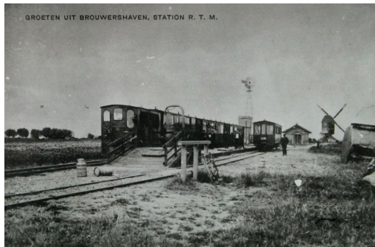
RTM-station Brouwershaven, begin 20ste eeuw.
