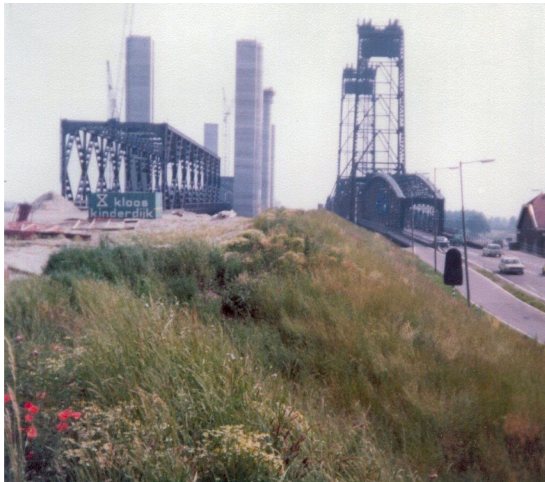
De oude Spijkernisserbrug uit 1904, werd in 1978 vervangen door een nieuwere, samengesteld uit delen van de oude Moerdijkbrug uit 1936. Na twee onveilige smalle rijstroken kwamen drie ruime rijstroken beschikbaar. De metro kreeg een eigen tunnel. 1977.
