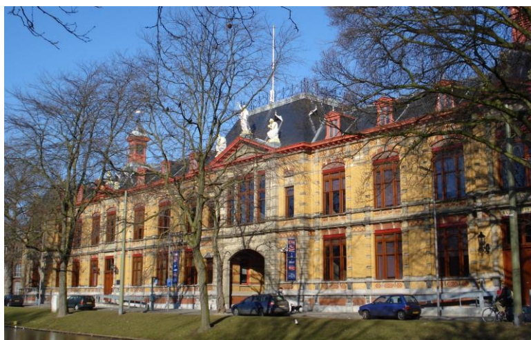
Het voormalige gerechtsgebouw van Rotterdam, gelegen aan de Noordsingel. Deze creatie van architect Willem Metzelaar uit 1899, is thans een rijksmonument en verzamelgebouw.
