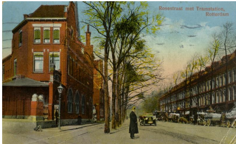
Het RTM-hoofdkantoor uit 1905 . Achter de diender het RTM-spoor 'onder de bomen'. Tussen het stationsgebouw en de bomenrij: het SS-boterlijntje naar de margarinefabriek, circa 1910 .
