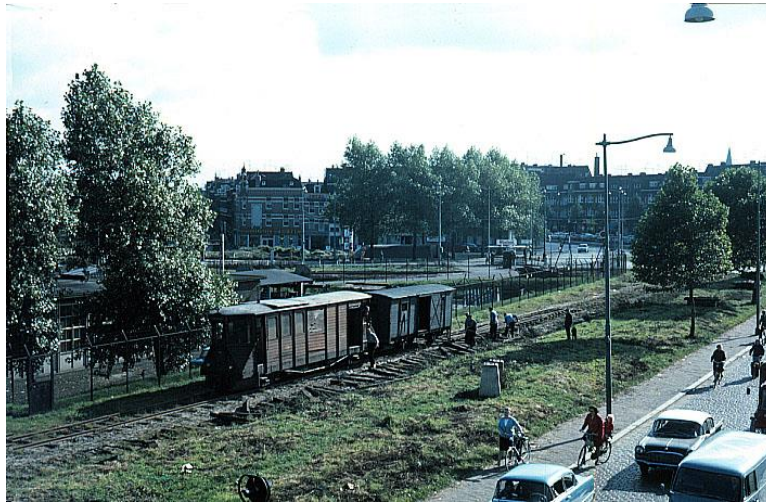
M 67 en wagen 619 bij het opbreken van het tweede spoor in de Tweede Rosestraat. 22 September 1966 .
