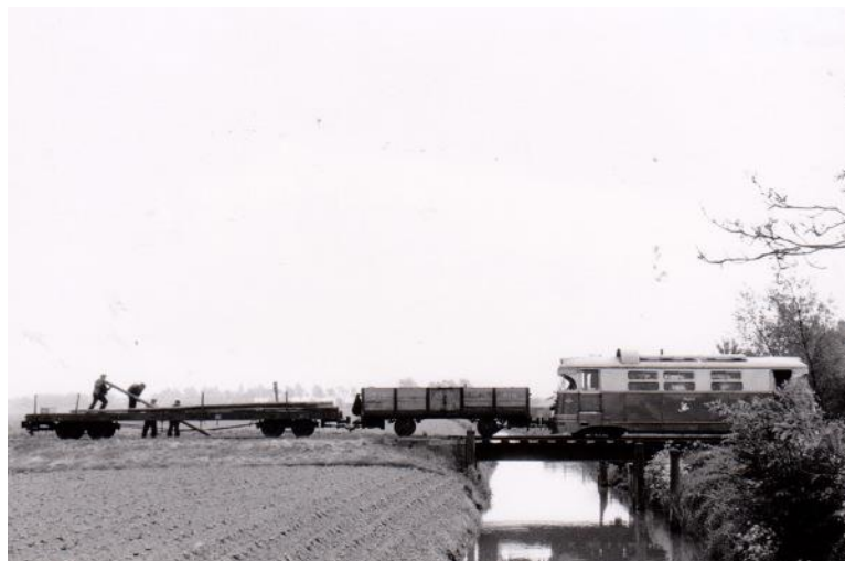
MD 1806 'Bergeend' + 228 en 883 steunen de opbraak bij Heenvliet, 19 mei 1966 . Vier mannen verplaatsen spoorstaven met blote handen.
