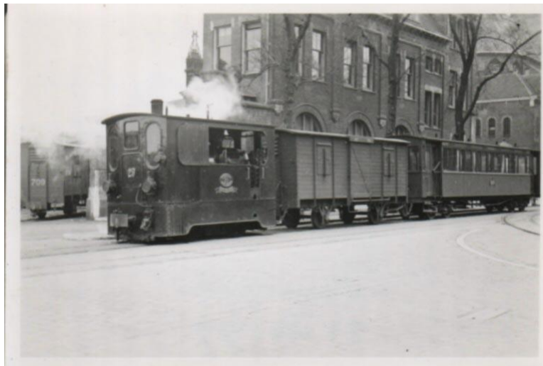
'Backertje' 29 met tram op het spoor 'onder de bomen' in de Rotterdamse Rosestraat. Het stationsgebouw achter de tram, is nu een gemeentelijk monument.
