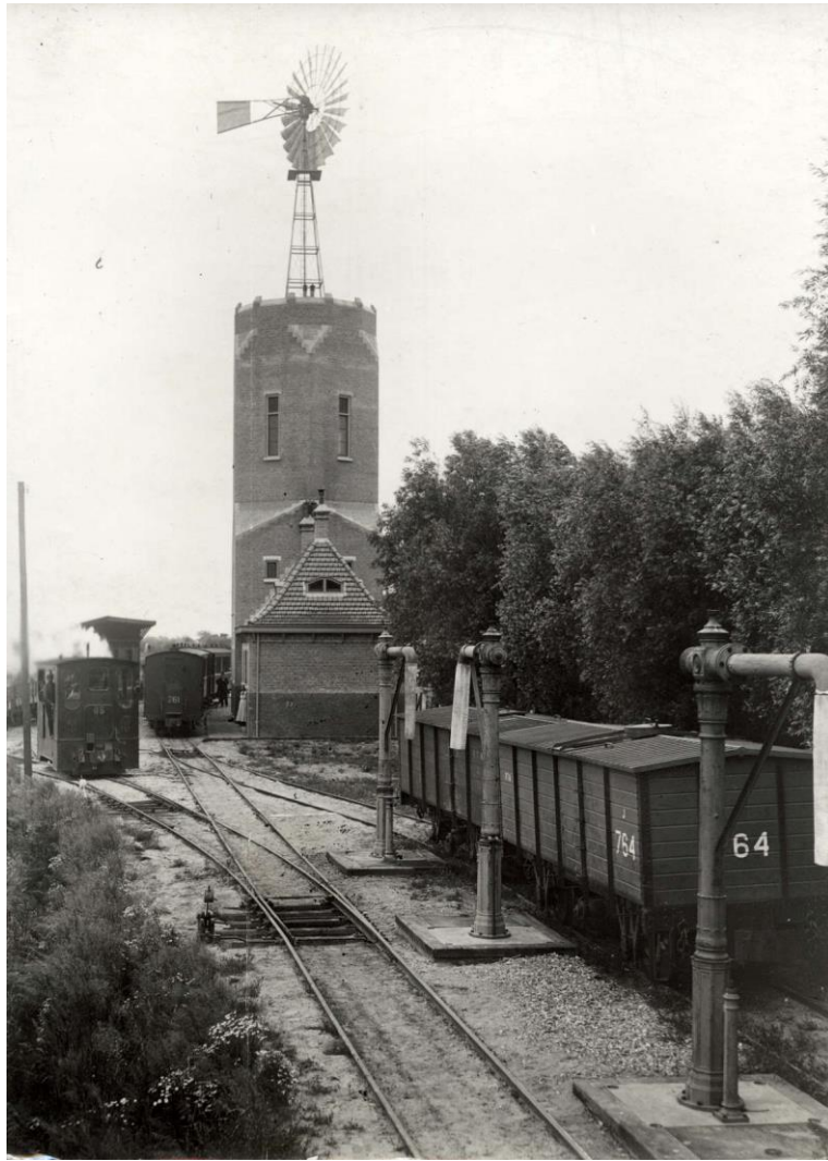
Burgh, station met watertoren en windmolen. Links loc 35 en rechts enkele waterwagens naast drie waterkolommen.
