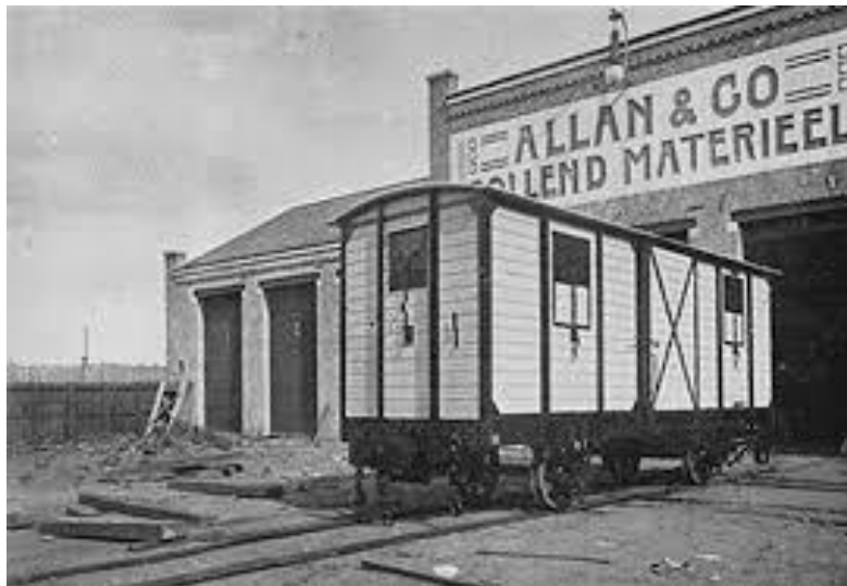
Eén van de drie gesloten goederenwagens van de TBC-serie 201-203, die bij de RTM de nummers 1103-1105 droegen. Fabrieksfoto bij Allan, Rotterdam, 1906 .
